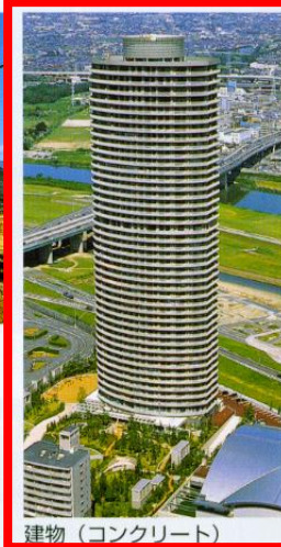
建物 (コンクリート)
