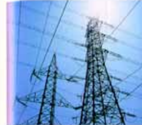
電線、鉄塔 (金属)
